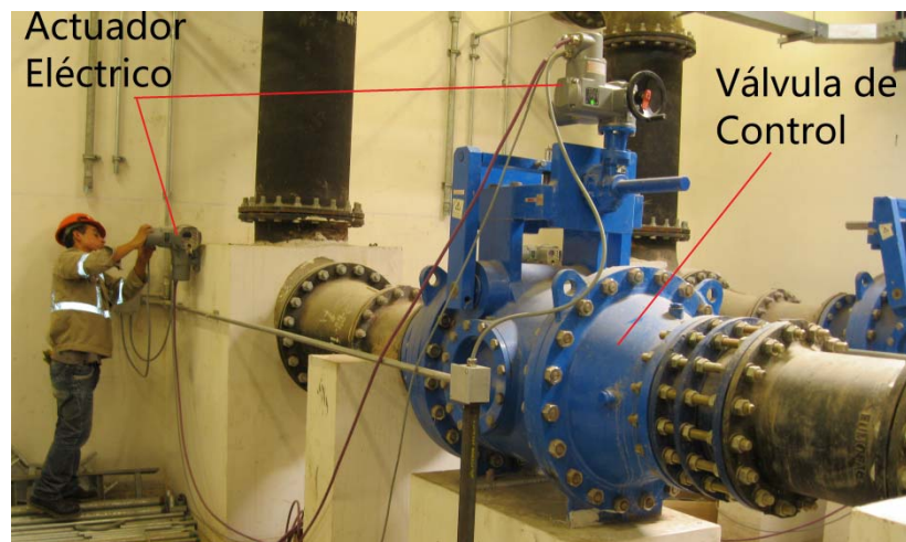
Figura 1: Válvula de regulación de caudal DN 250 con actuador eléctrico Autor: Elaboración propia (2018)
